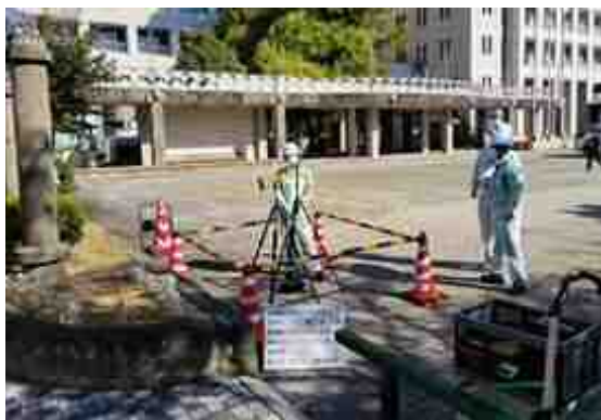
訓練実施状況(豊橋市:豊橋市役所)
