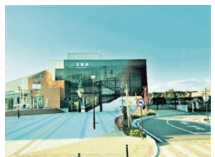
写真12 常磐線双葉駅の駅舎(車窓より)
