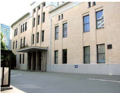
写真2. ノリタケカンパニーリミテド本社(名古屋市西区)
